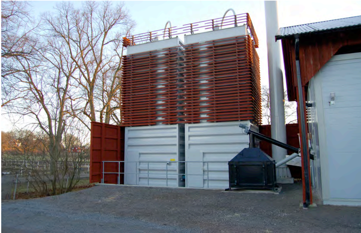
2 x 40 m 3 silo med yttre träbeklädning.
