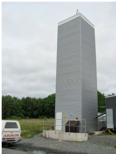
80 m 3 silo med yttre plåtbeklädnad.
